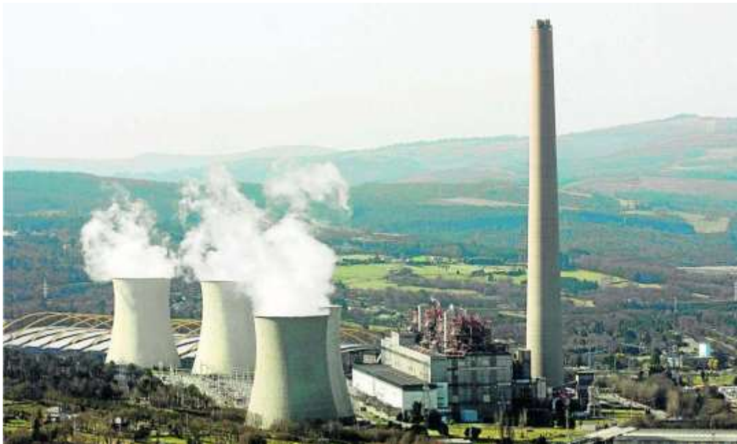
Figura 10.2. Central Térmica de As Pontes de García Rodríguez (A Coruña). Fotografía: Economía Digital Galicia.
