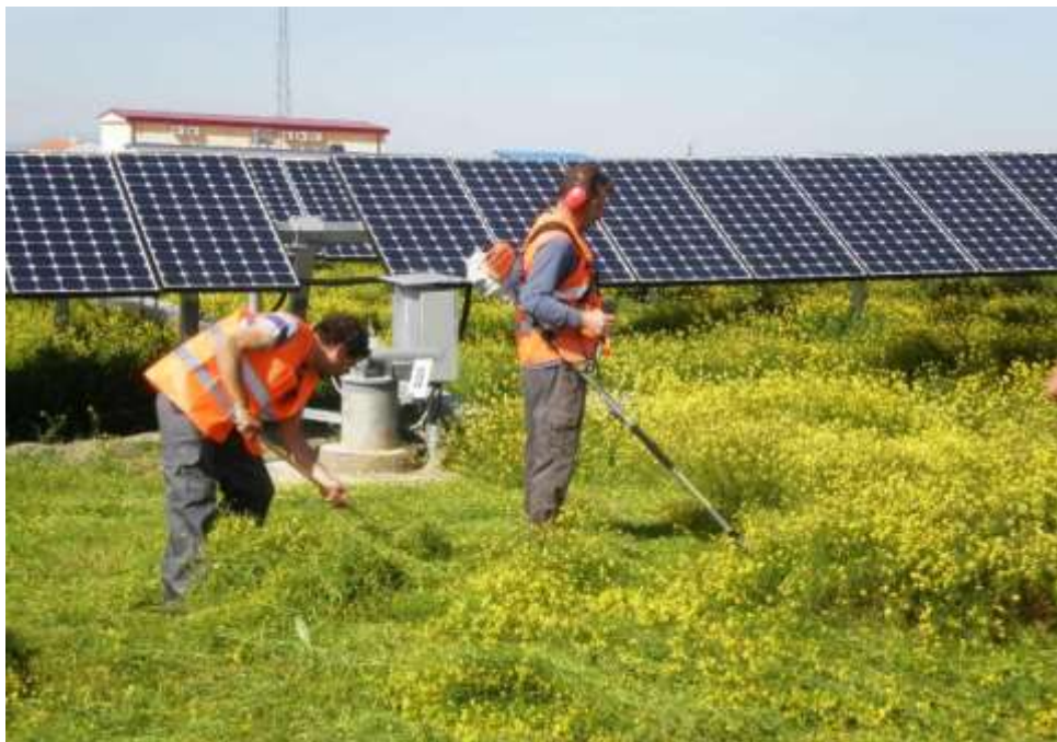
Figura 8.19. Control de vegetación mediante desbroce manual en un Parque Solar. Fotografía tomada de Servex Ingenieros.
