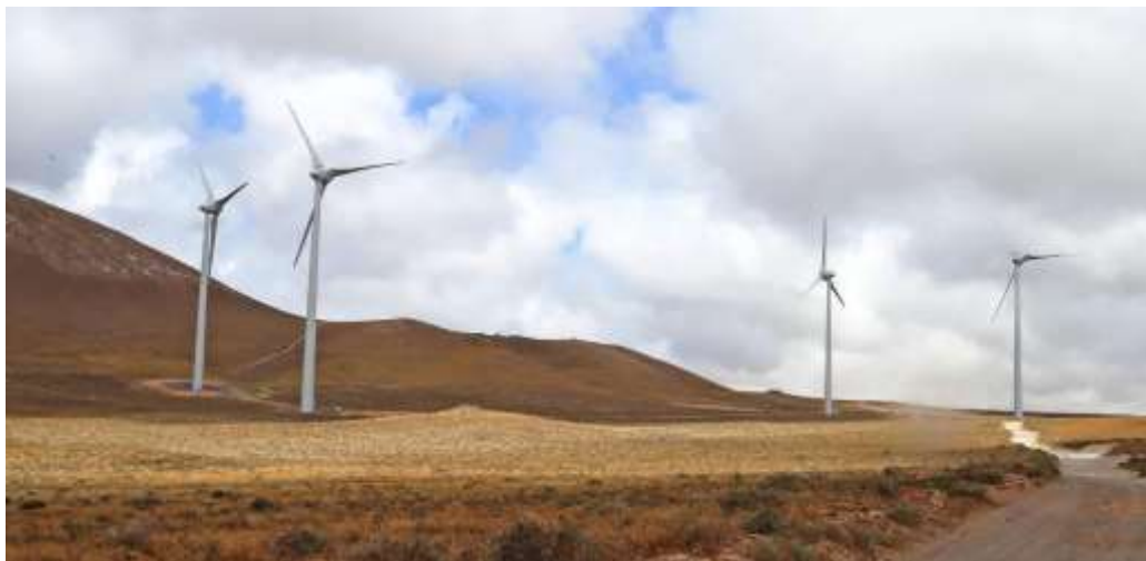
Figura 8.7. Vista del Parque Eólico de Arrecife (San Bartolomé en Lanzarote) ubicado en la Reserva de Biosfera de Lanzarote. El parque este compuesto por 4 aerogeneradores (altura del buje de 85 m. Diámetro rotor de 71 m. Altura máxima, con las palas, de 120 m), una potencia total instalada de 9,2 MW y produce 27.150 MW/h al año. Fotografía: La Voz de Lanzarote.
