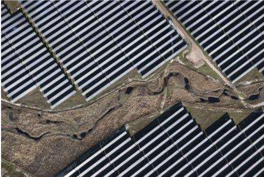
Figura 8.3. Vista aérea del Parque Fotovoltaico de Talayuela (Cáceres). El Parque ocupa un polígono de 820 ha, de las cuales 500 ha (61%), están ocupadas por paneles solares. Algunos de los elementos del paisaje primitivo, como el curso fluvial y las charcas que se muestran en la figura, se han preservado, generando islas en medio de un nuevo paisaje artificial de reducida naturalidad y diversidad. Fotografía: El País.
