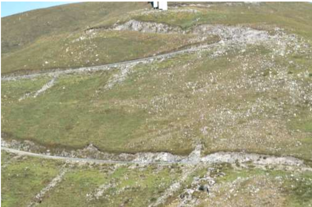
Figura 10.60. Detalle de la erosión vinculada al vial de acceso al Parque Eólico instalado en el Monte Cadramón (año 2022).
