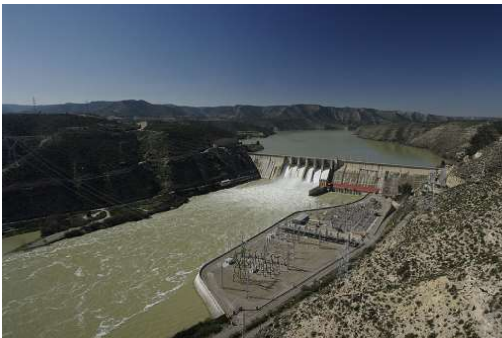
Figura 3.11.- Presa y Central de Mequinenza
