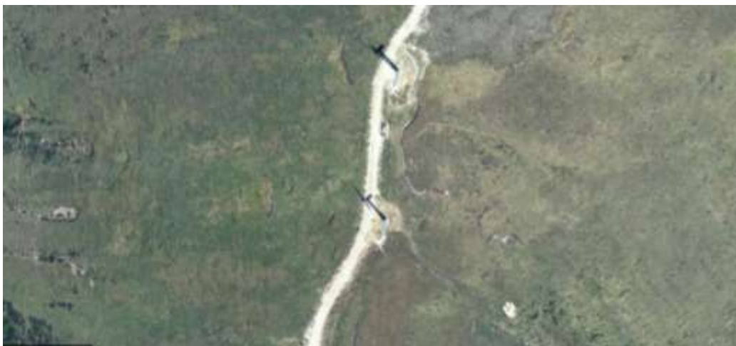
Figura 10.15. Vista de detalle de una parte de un Parque Eólico en la Serra do Xistral (Muras-O Valadouro, Lugo), construido sobre una turbera de cobertor activa (Nat-2000 7130*). El área forma parte del LIC-ZEPVN Serra do Xistral (Zona núcleo de la Reserva de Biosfera).
