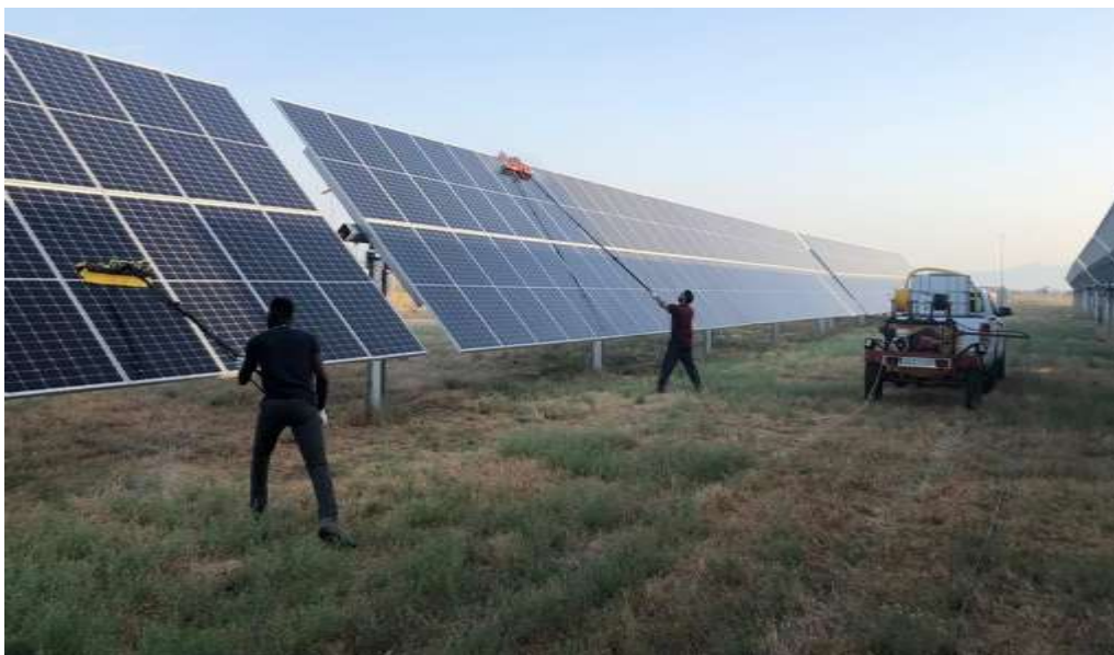
Figura 8.32. Ejemplo de limpieza manual en una Planta Fotovoltaica. Imagen publicada en el Dossier de Trust Ingeniería de Mantenimiento (Olivenza, Badajoz).
