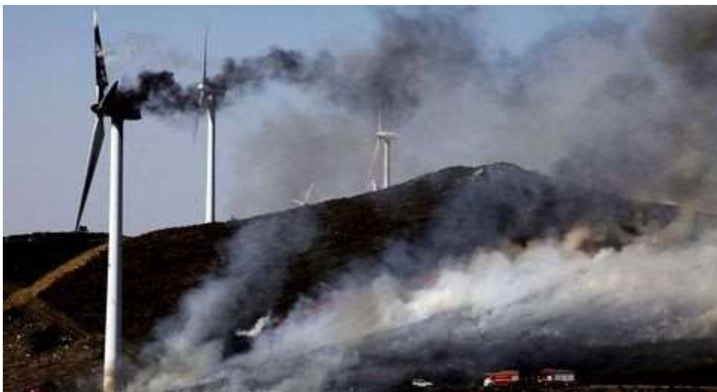
Figura 10.54. El incendio de un aerogenerador en el Parque Eólico de Outes (A Coruña), provocó un incendio forestal de 20 ha en el monte Tremuzo. Fotografía: La Voz de Galicia (27/03/2012).
