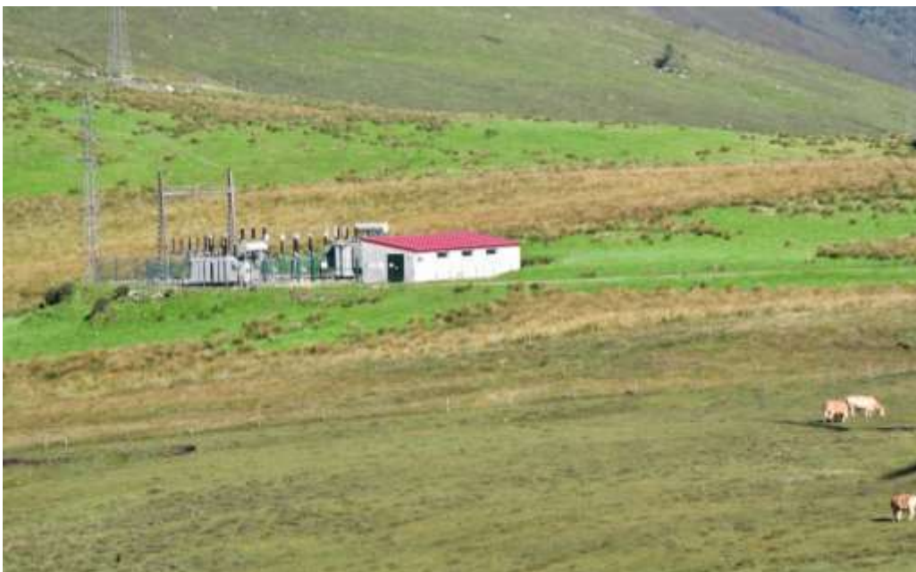
Figura 10.63. Estación eléctrica emplazada sobre la antigua turbera de Chan da Cruz. El área que rodea la estación aparece transformada en un pastizal y un juncal de escasa reducida.
