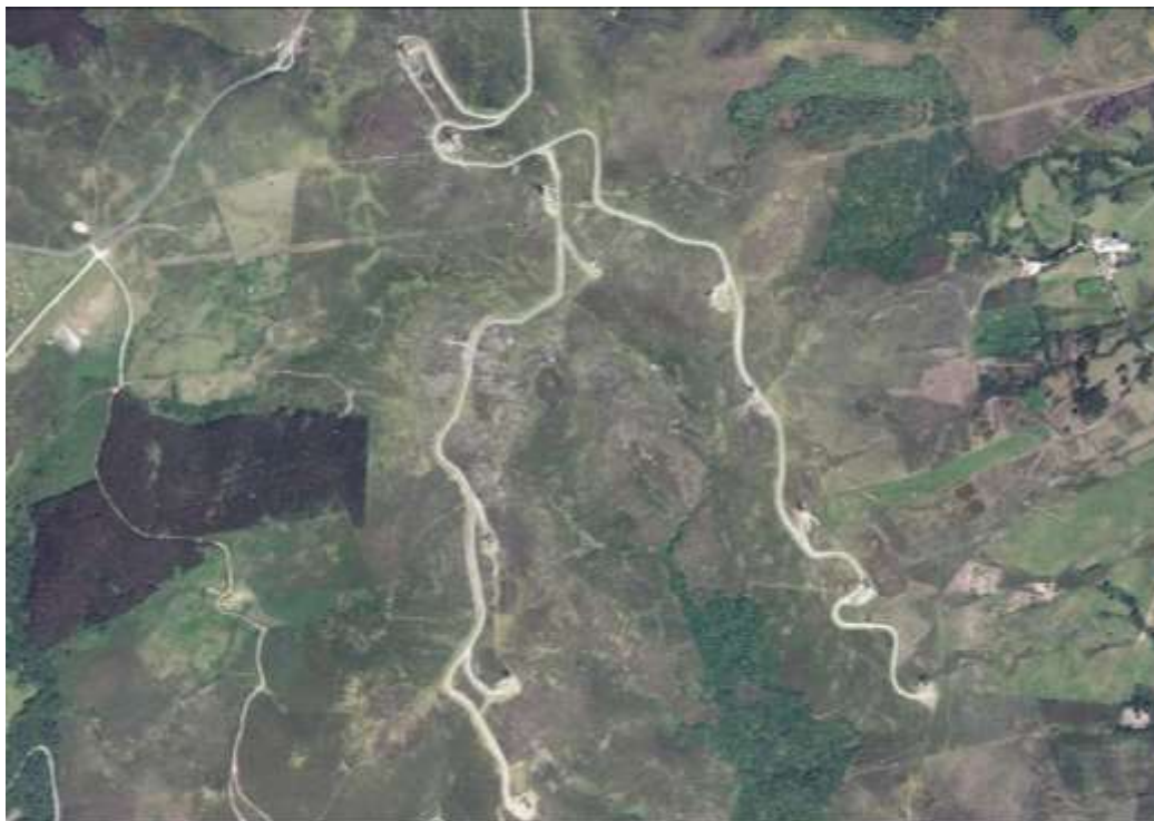
Figura 10.31. Instalación de parques eólicos en la zona tampón de la Reserva de Biosfera Terras do Miño, sobre brezales húmedos y turberas altas (Nat-2000 4020*, 7110*).
