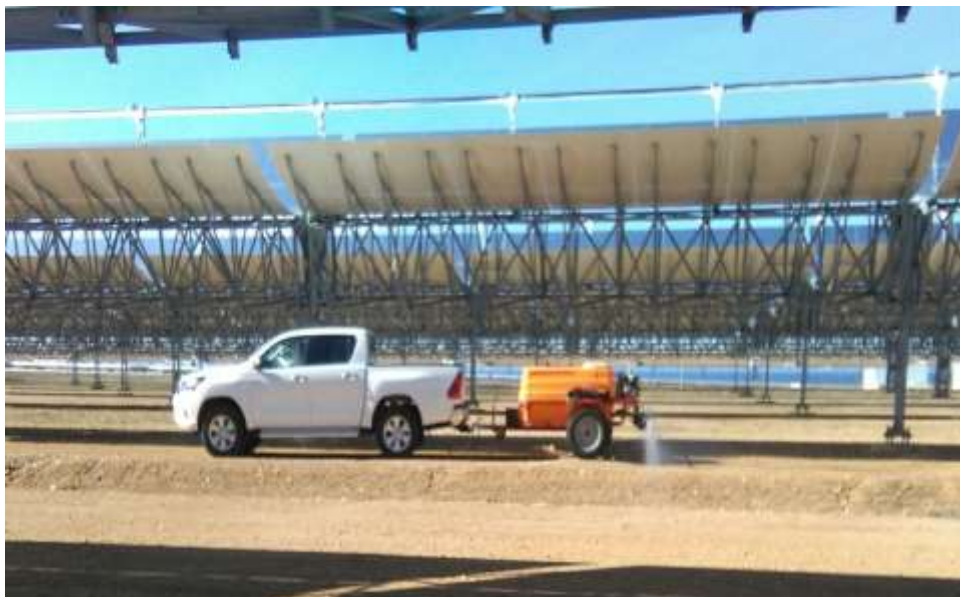
Figura 8.18. Tratamiento de herbicida en una planta termo solar. Fotografía tomada de Servex Ingenieros.
