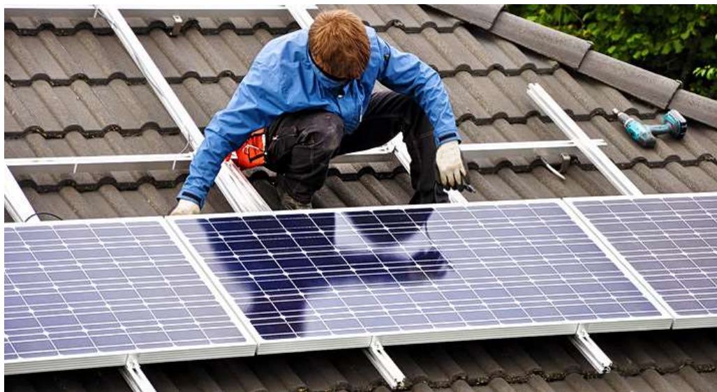
Figura 3.56. Instalación de paneles fotovoltaicos en una vivienda. Fotografía: Avatar Energía
