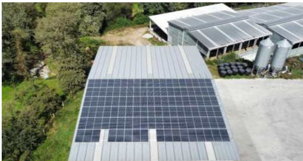
Figura 8.11. Instalación fotovoltaica para autoconsumo (50kw) de una granja en Guitiriz situada sobre las propias instalaciones de la granja, Reserva de Biosfera Terras do Miño. Fotografía; Mecánica Solar, O Saviñao.
