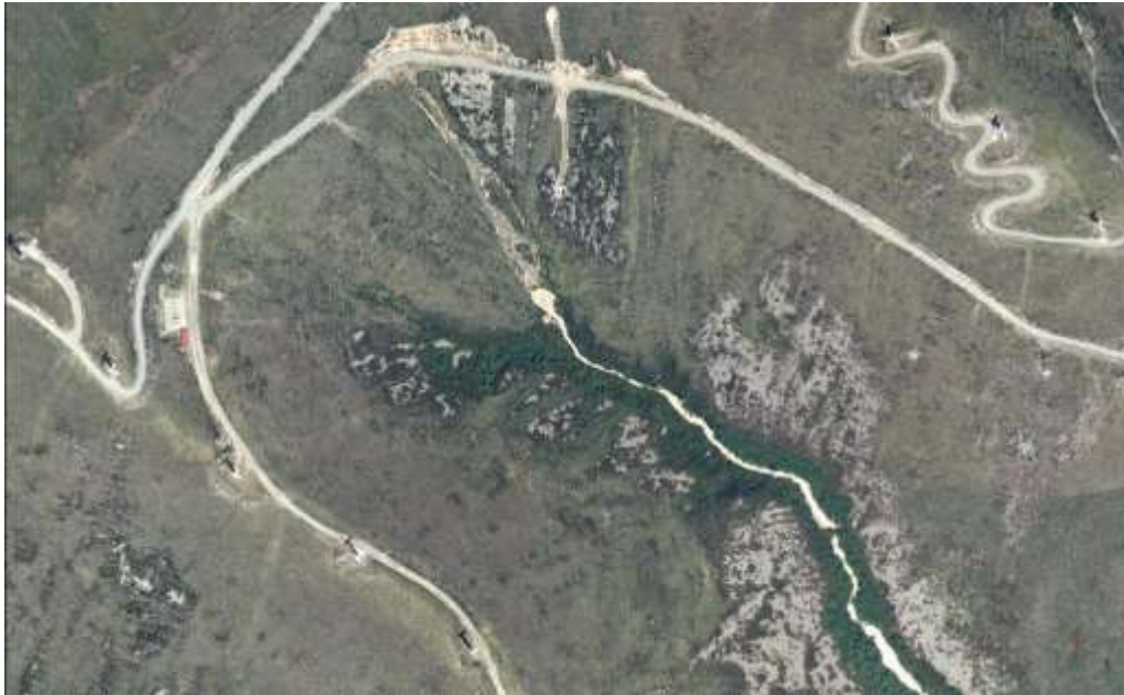
Figura 10.37. La creación y modificación de los viales para la construcción del Parque Eólico generan serios impactos sobre la dinámica superficial de los humedales de montaña de la Serra do Xistral, que en las áreas cuminales de Chan do Lamoso (LIC-ZEPVN Serra do Xistral. Zona Núcleo Reserva de Biosfera) se emplaza sobre un depósito coluvial formado durante el Pleistoceno Superior, y que resulta fácilmente alterable cuando pierde la cobertura de vegetación y recibe un gran volumen de agua. En la parte superior central se observa una zona erosionada al modificarse la hidrología superficial durante las obras de adaptación del vial.
