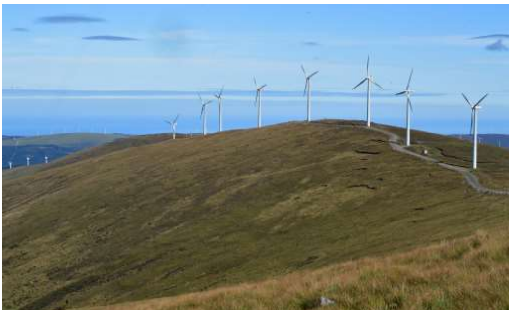
Figura 10.73. Vista general de la línea de aerogeneradores y del vial del parque eólico que discurre entre el Alto de Chan do Lamoso y Chao do Lago (O Valadouro-Muras, Lugo), instalada sobre a la turbera de cobertor.
