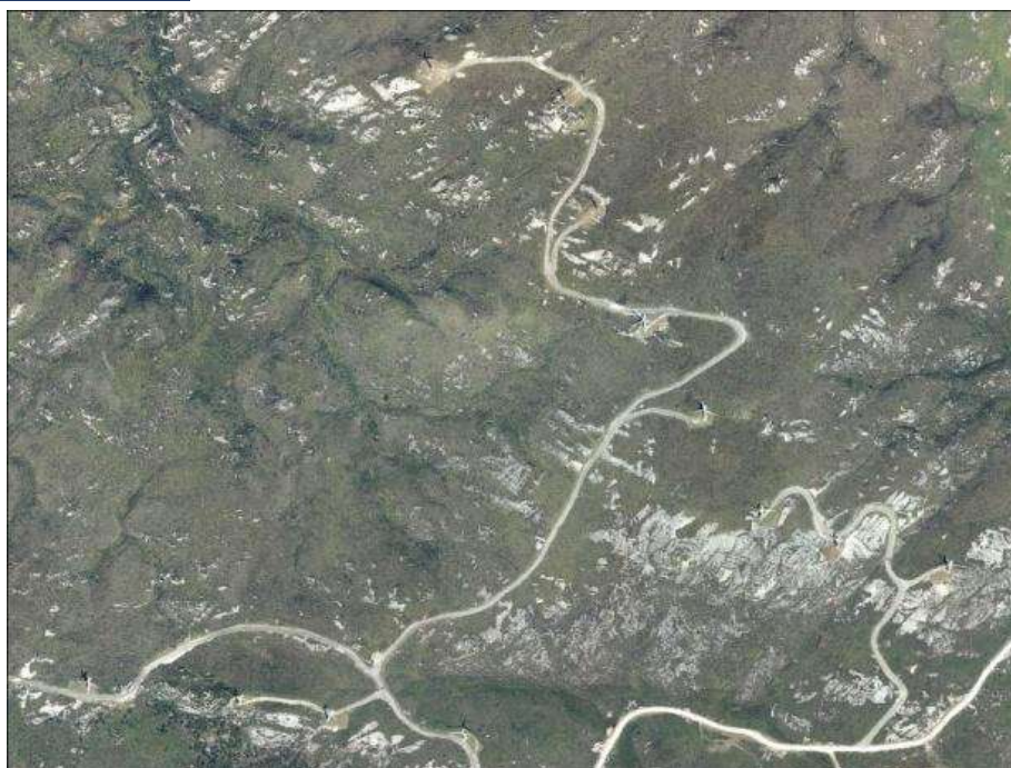
Figura 10.22. Instalación de un parque eólico en la actual ZEC Serra do Xistral (zona núcleo de la Reserva de Biosfera Terras do Miño) sobre turberas altas y, brezales húmedos (Nat-2000 7110*, 4020*), entre 2003 (ortoimagen SIGPAC) y 2011 (ortoimagen del PNOA).
