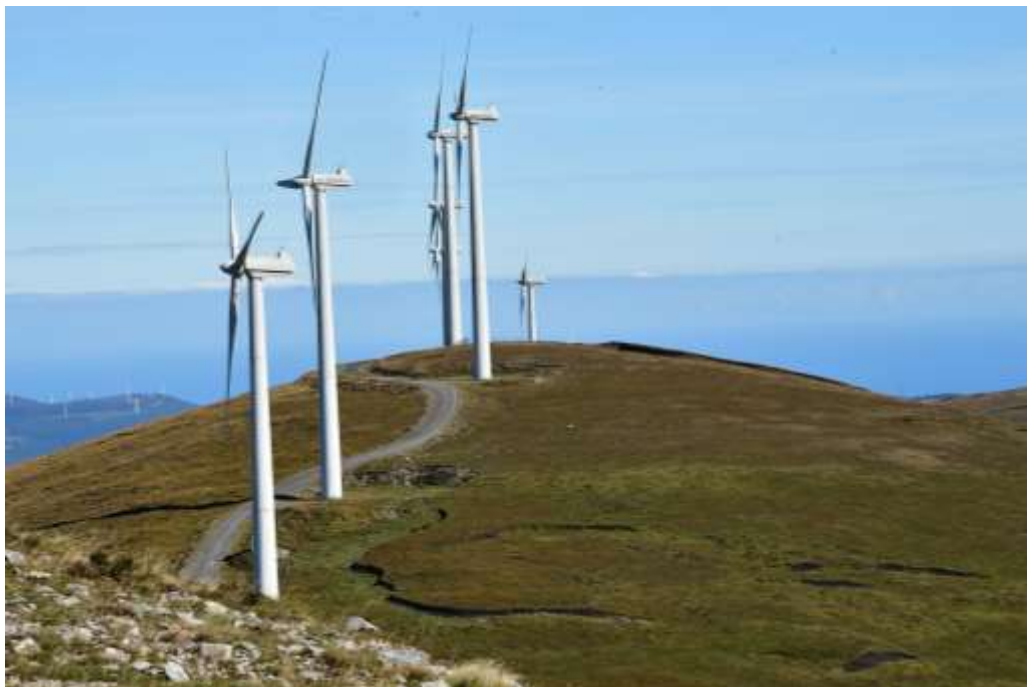
Figura 10.70. Turberas de cobertor (Nat-2000 7130*) de Chan do Lamoso (O Valadouro – Muras, Lugo), en la ZEC Serra do Xistral) afectadas por la construcción de un Parque Eólico
