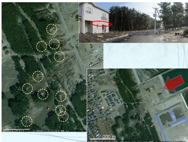
Imagen 1. En los círculos amarillos se aprecian viviendas rodeadas de bosque, en el círculo rojo una vivienda protegida por el bosque con afectaciones leves. La flecha roja muestra una infraestructura destruida por la ola del tsunami, detrás un grupo de autos estacionados protegidos por la línea de bosque 4
